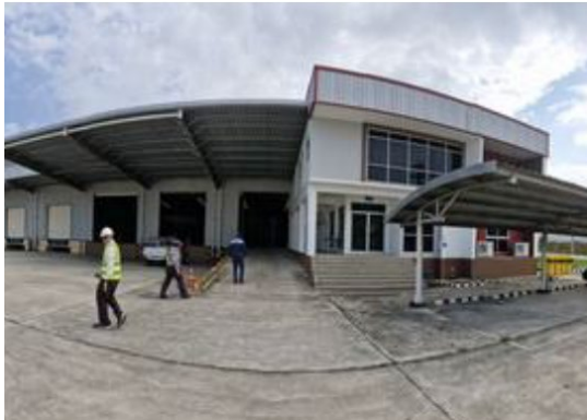
สภาพทั่วไปบริเวณหน้าอาคาร
