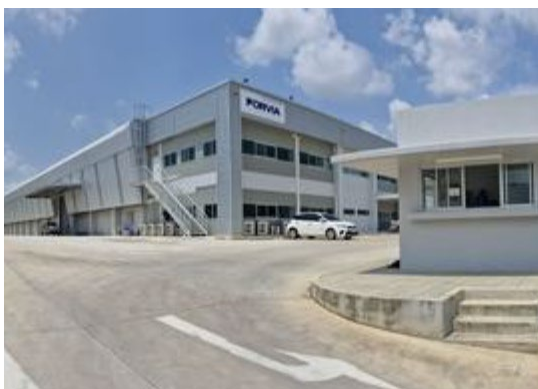
สภาพทั่วไปบริเวณหน้าอาคาร
